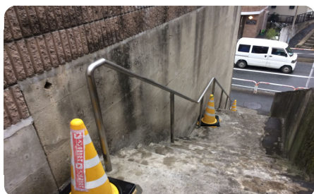
急階段に手すりを設置 (成増2丁目)
