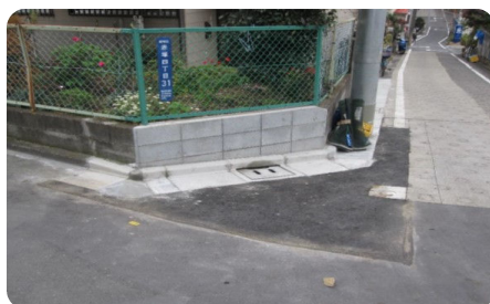
隅切りを作り電柱を移設 (赤塚4丁目)
