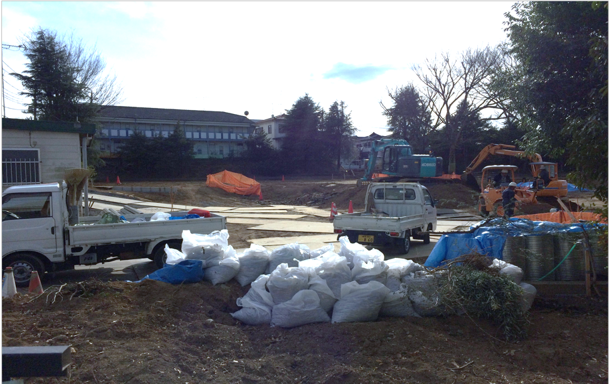
見通しのよい明かる公園へと工事が進められています
